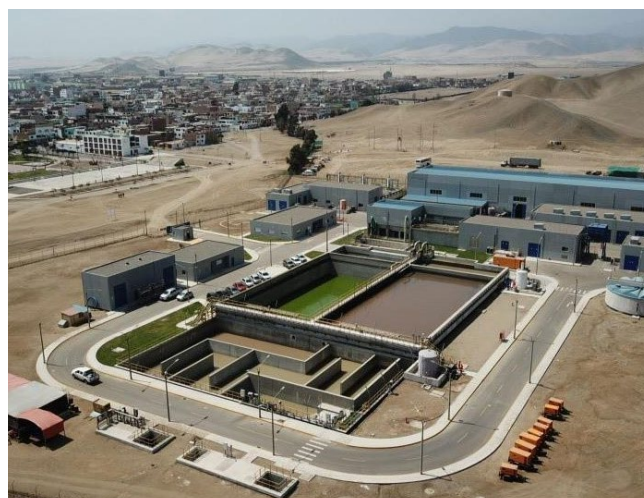
Tecnología. Planta Desaladora de Agua de Mar PROVISUR, San Bartolo, Lima.
