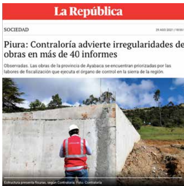
Las labores de supervisión de obras y servicios públicos en la provincia de Ayabaca revelaron alertas de irregularidades que podrían afectar la calidad de los proyectos de inversión millonaria, informó la Contraloría General de la República.
