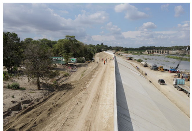
Rehabilitación de las defensas ribereñas - Tramo Presa Los Ejidos - Puente Cáceres
