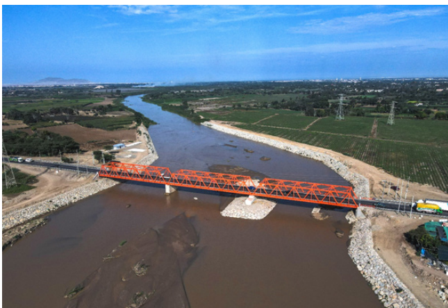
Reconstrucción de los sectores afectados por el Fenómeno del Niño en la Autopista del Sol, sector Puente Reque.
