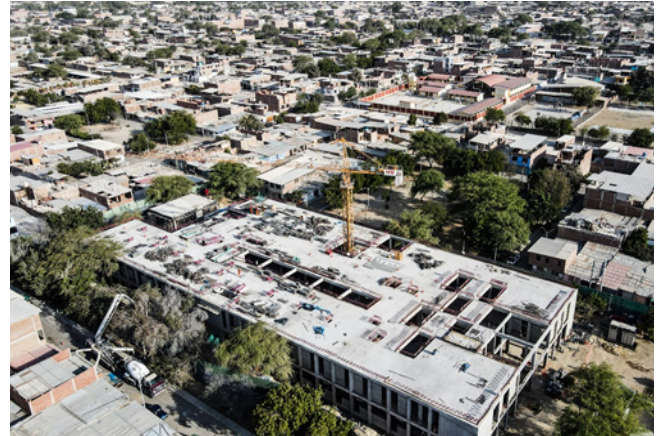
Hospital de Castilla - Piura.
