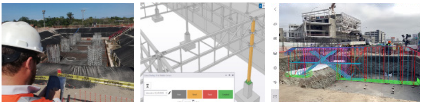
Figura 4: Captura de actividades de terreno integradas a modelo BIM. Imágenes por TSC Innovation - Aceros Arequipa
