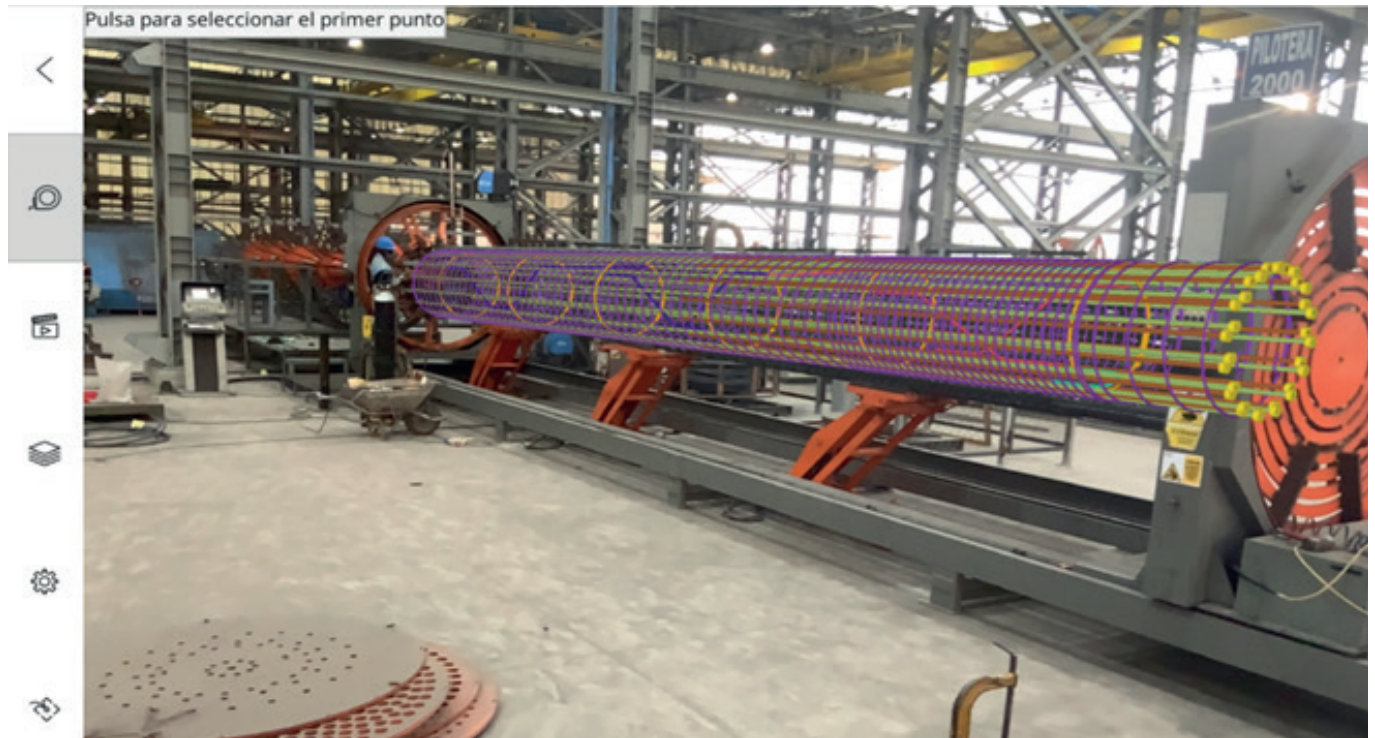
Figura 5: Robot para armado de pilotes y columnas circulares con realidad aumentada para control de calidad. Imágenes por TSC Innovation - Aceros Arequipa
