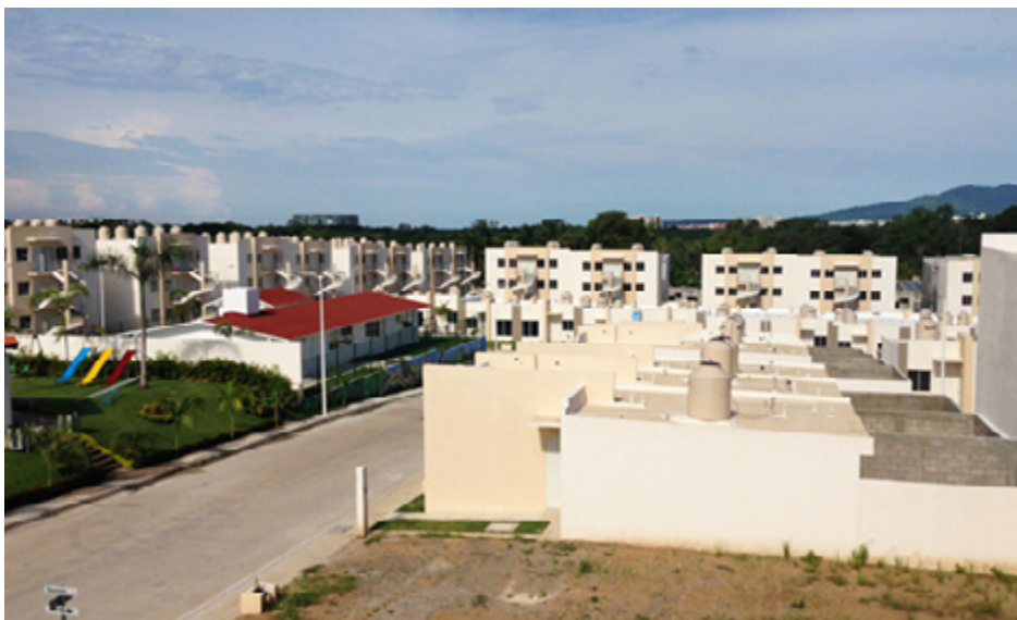
Figura 12. Desarrollo Puerta del Mar, Quintana Roo-México sobre 322 hectáreas se construyen más de 25 mil viviendas (Foto: casaopcion.com)
