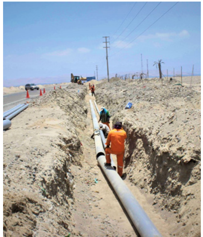
Figura 6. Obras de agua y desagüe para proyectos urbanos formales pueden incluir participación privada (Fuente: andina.com.pe)
