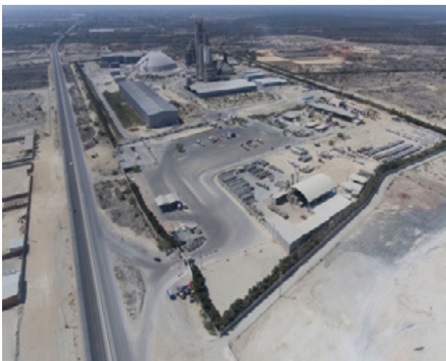
Figura 2. PLANTA CEMENTERA DE PACASMAYO EN PIURA
