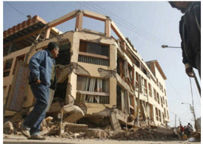
Figura 12. Un sismo en Lima similar al de Pisco, provocaría 51 mil muertos y la destrucción de 549 mil viviendas por la informalidad de las construcciones.
