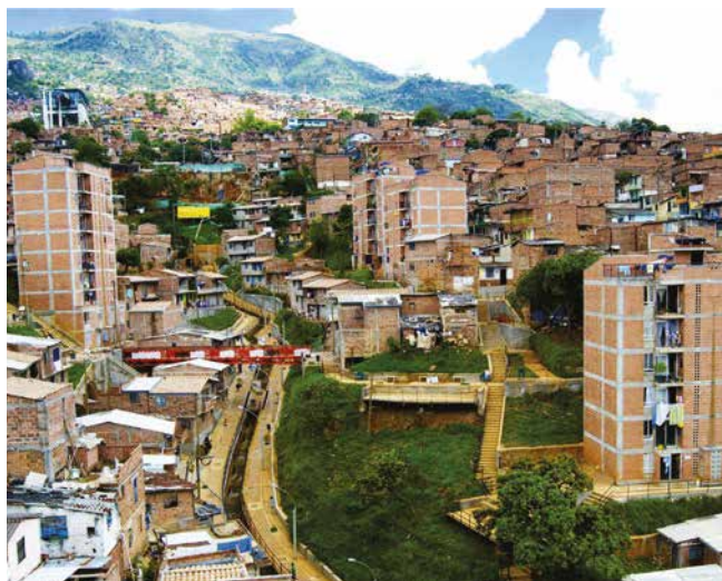
Proyecto Nuevo Sol de Oriente Zona Nororiental de Medellín - Colombia
