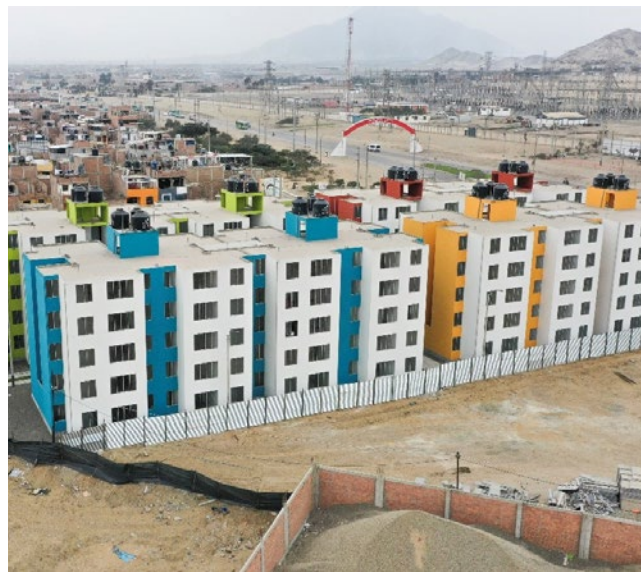
Condominio Residencial Cuatro Suyos ubicado en región La Libertad.
