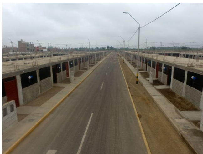
Viviendas sociales. Foto: MVCS.
