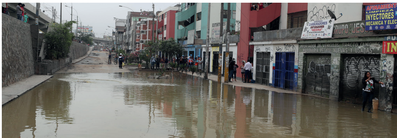
La limitada inversión en renovación de redes de agua y desagüe -alrededor del 20% en Lima- restringe la densificación urbana y expone fallas operativas, como el aniego ocurrido en el año 2019 en el distrito de San Juan de Lurigancho.
