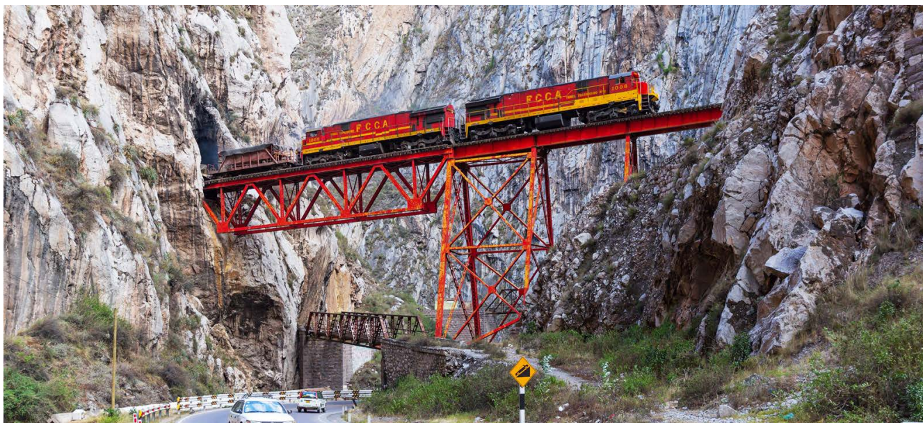
Foto: Viaducto Infiernillo Autor: David Gubler bahnbilder.ch
